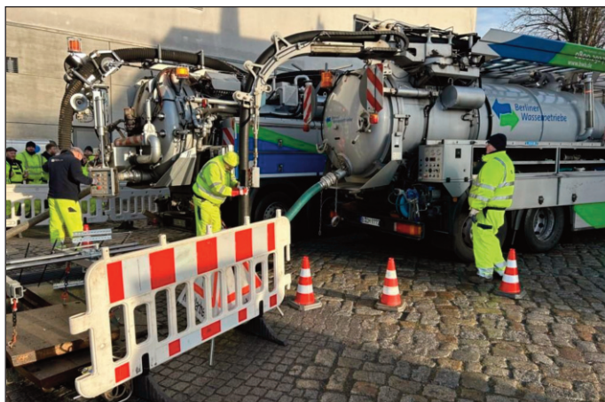
Die Wasserbetriebe pumpen mit Spezialfahrzeugen das Wasser aus den Regenauslaufkammern.
